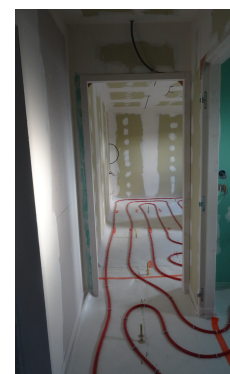
Pose des planchers chauffants Fév 2016
