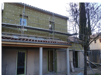
Travaux d'isolation extérieure Meysse
